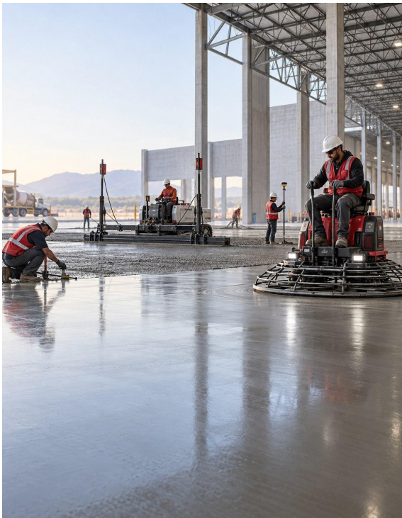
Enrasado, verificación y allanado deben avanzar como un solo sistema coordinado.
