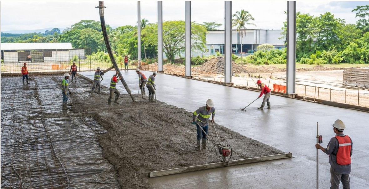
La continuidad entre descarga, consolidación, enrasado y enderezado controla geometría y superficie.
